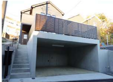
地盤改良工事
